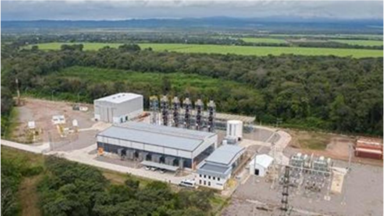
FIGURE 2.25 EXEMPLE DE CENTRALE ELECTRIQUE AVEC PARC PHOTOVOLTAÏQUE
